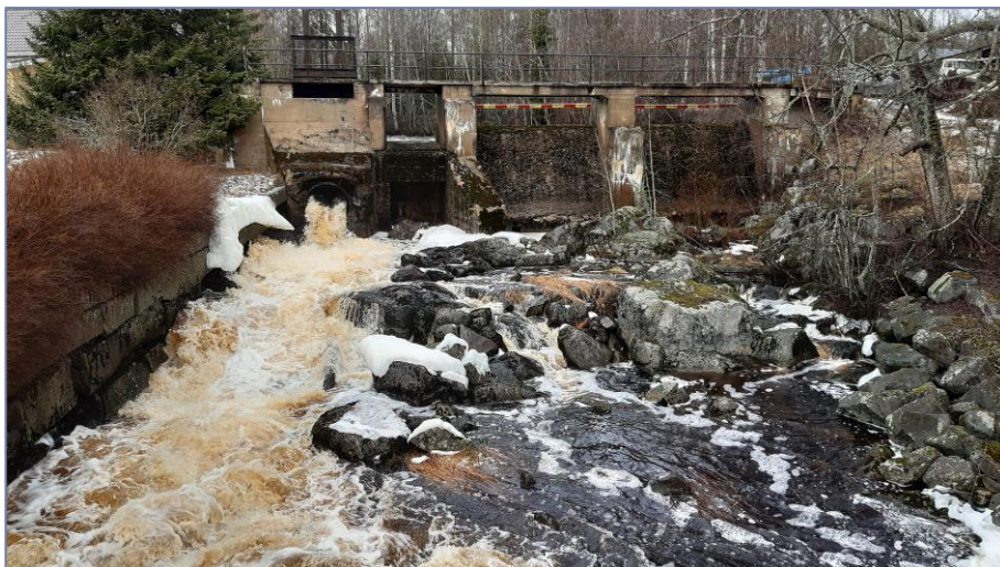
Kuva 5.3. Karjulankoskessa oleva pato on totaalinen nousueste, joka estää taimenten vaellukset vesireitin yläosalle.
